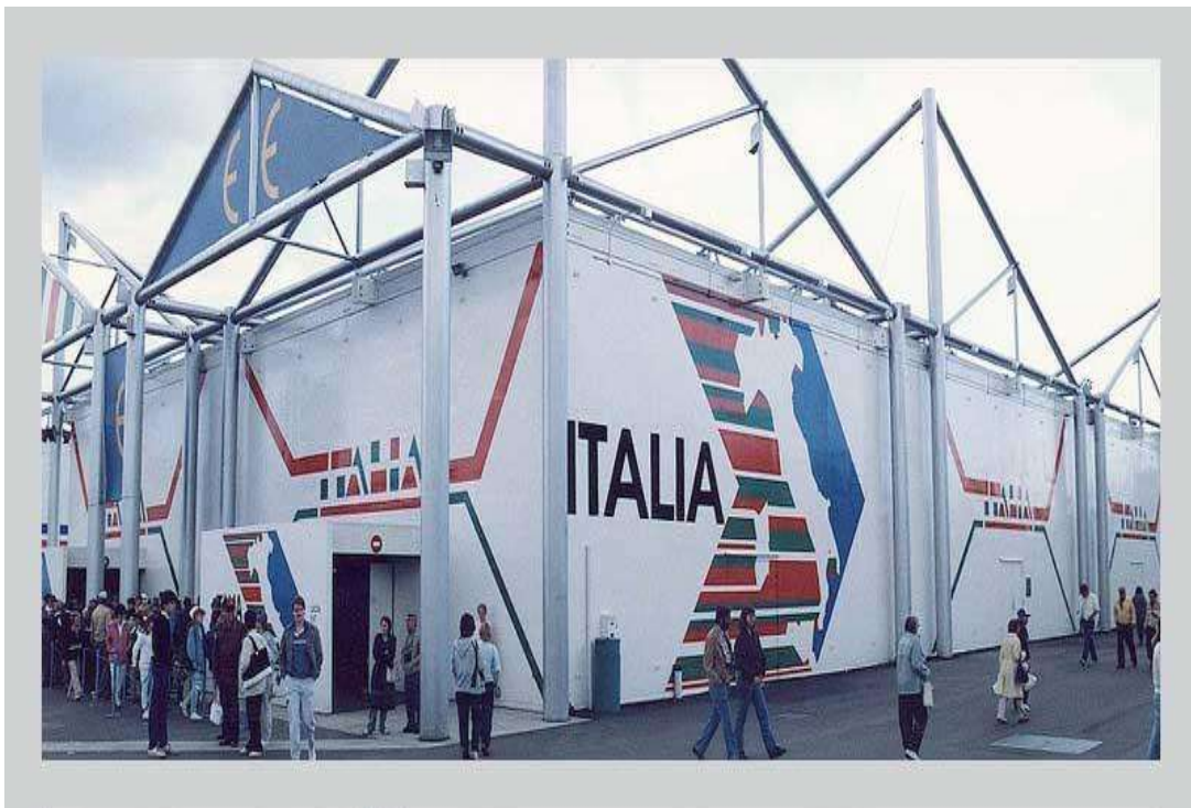
استفاده از سازه سبک در ساخت سالن ایتالیا در اکسپو ۱۹۸۶ ونکوور کانادا
