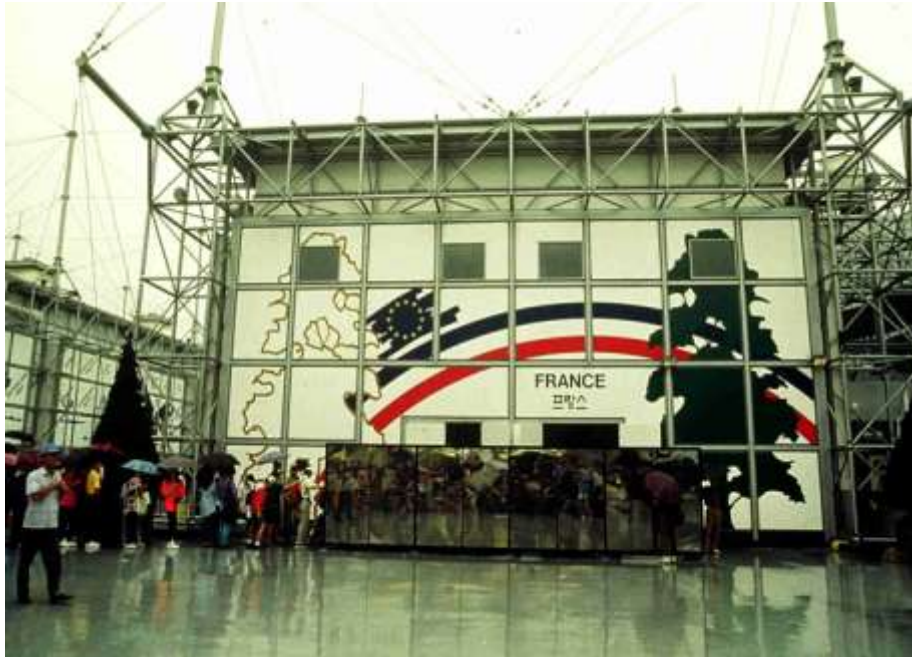
استفاده از سازه سبک در ساخت سالن فرانسه در اکسپو نی جون کره جنوبی ۱۹۹۳
